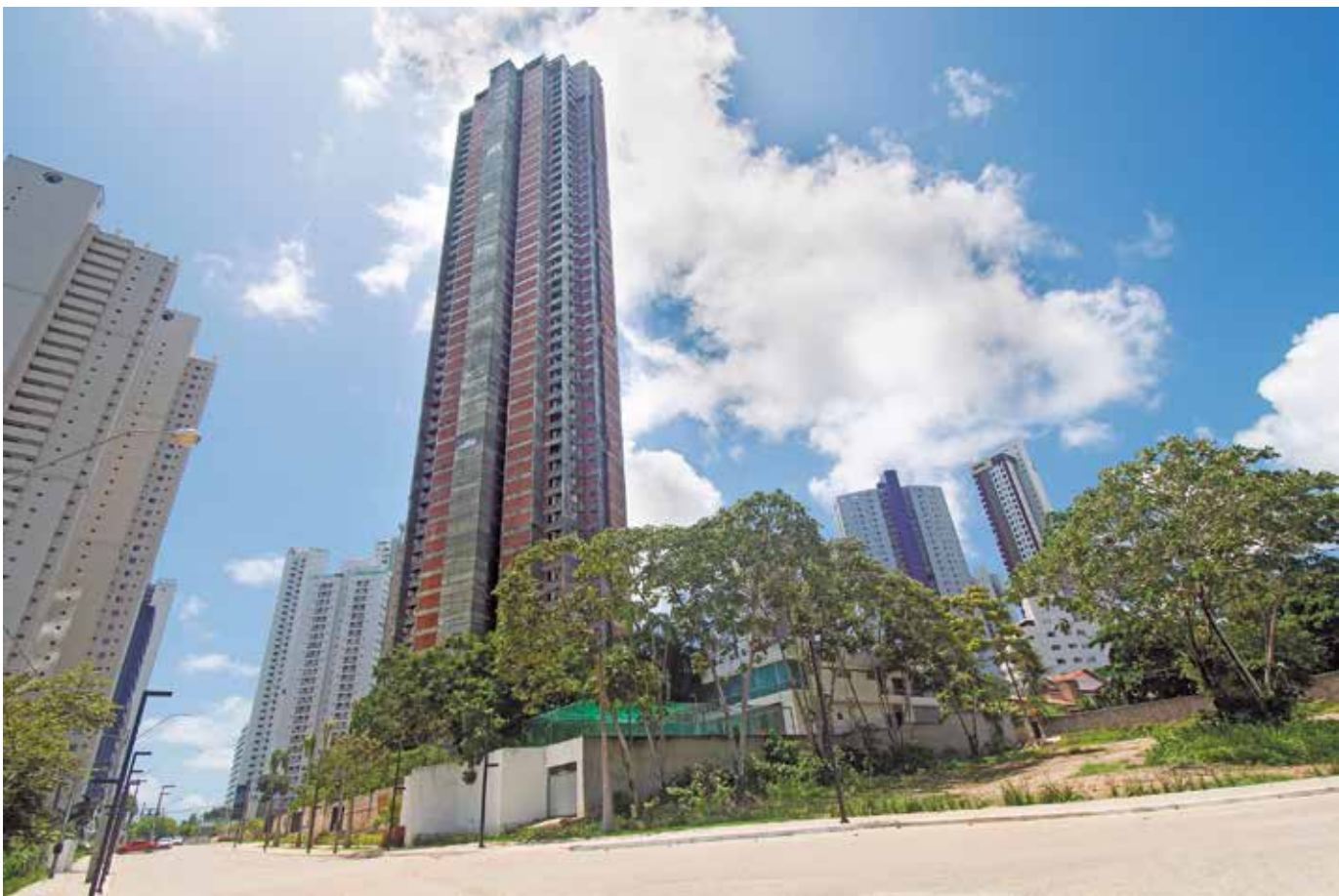
Residencial Liége, localizado no Altiplano, prometia ser o edifício mais alto da capital, mas está com obras paradas desde 2017
